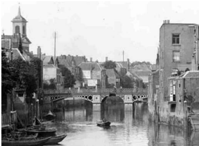
De Nieuwbrug omstreeks 1910. In het midden is het mastgat te zien. Er konden een paar planken worden weggehaald waardoor schepen met staande mast de brug toch konden passeren
